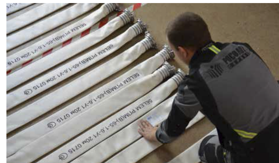
Проверка пожарных рукавов
