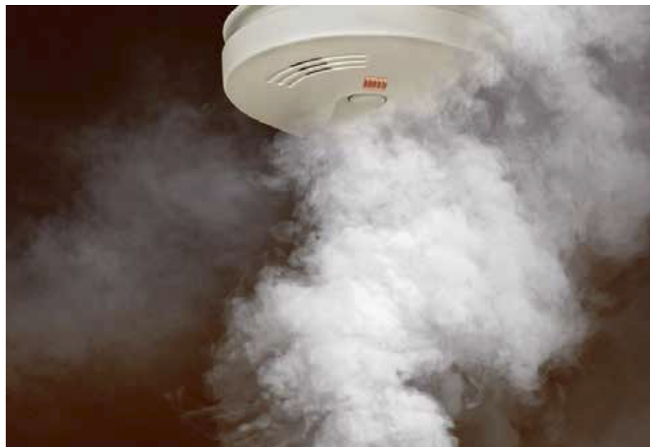
Проверка дымовых детекторов
